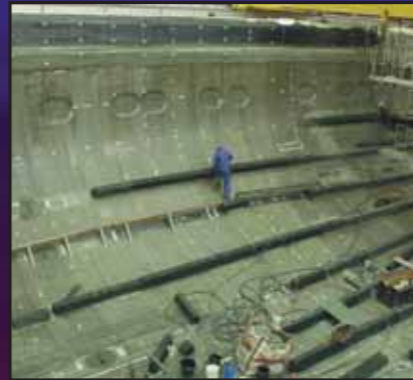
Formazione di nervature per costruzioni navali in vetroresina.
